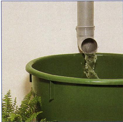
Die Standortwahl ist für eine Regentonne keine Frage. Sie steht da, wo das Regenwasser von den Dachflächen über ein Fallrohr abgeleitet wird.
